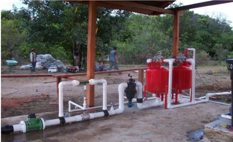
Fig 1. Estación de filtrado con filtros de arena y malla retrolavado automático.
